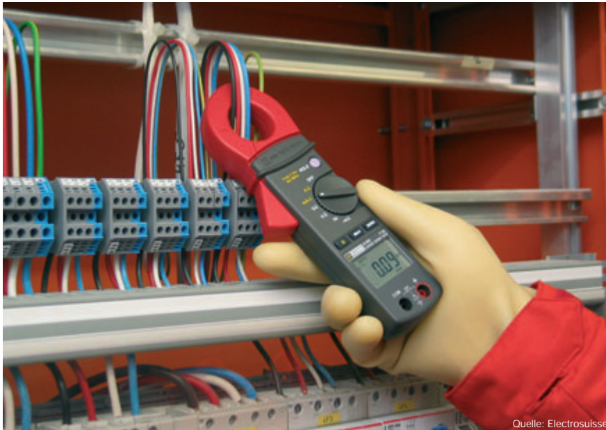
Bild 2 Leckstrommessung
