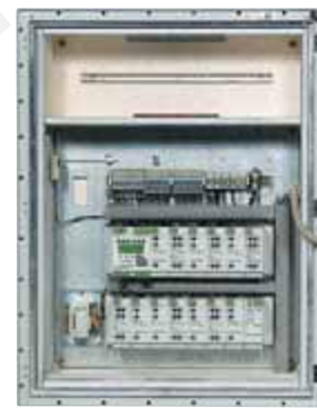
Dezentrale-CPS Unterstation auf Etage oder Brandabschnitt
